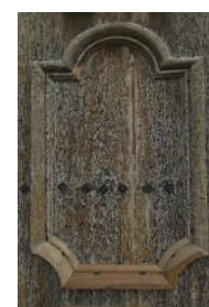
Toute la porte est en noyer. Certaines moulures ont été remplacées, et du bois a été inséré pour remplacer la matière manquante. Et de nouveaux clous ont été forgés.
