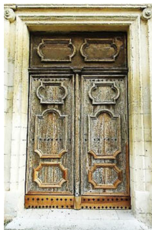
Toute la porte est en noyer. Certaines moulures ont été remplacées, et du bois a été inséré pour remplacer la matière manquante. Et de nouveaux clous ont été forgés.
