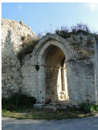
À gauche, la porte avant les travaux. Après la restauration, plusieurs rangs de pierre de taille remplacent les éléments disparus.
