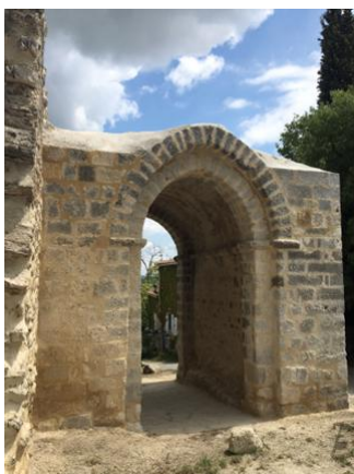
À gauche, la porte avant les travaux. Après la restauration, plusieurs rangs de pierre de taille remplacent les éléments disparus.
