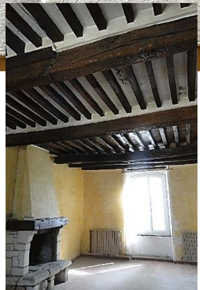
Ci-dessus : transcription des deux premières pages du prix-fait ou devis rédigé par le notaire Reynaud en 1551, et la première page du document original conservé aux archives départementales des Alpes-de-Haute-Provence. Ci-contre: vue de l'intérieur du bâtiment en 2020 avant sa rénovation: le plafond ancien n'a malheureusement pu être conservé.
