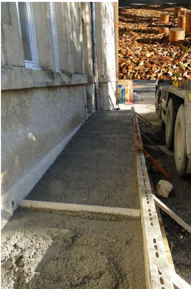
Aménagement d'une rampe PMR d'accès aux classes
