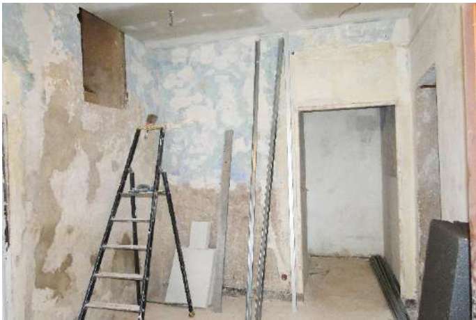
Intérieur du presbytère en travaux, février 2023
