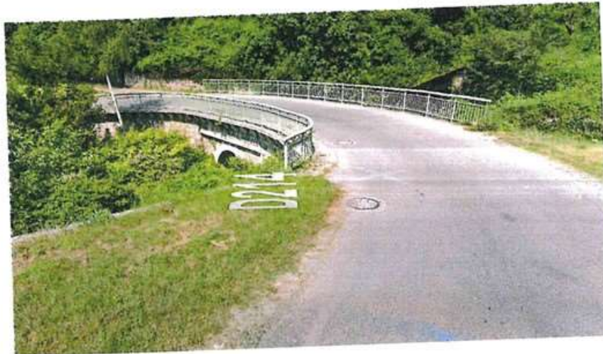
- Garde -corps sur OA - photo 2
