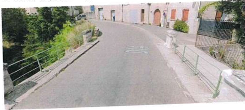
- Garde -corps sur OA - photo 1
